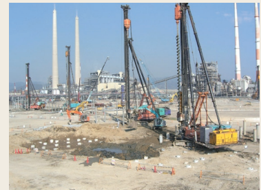
東ソーグループによる南陽の新 MDI，アニリン，一酸化炭素設備の建設
