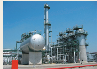
東ソーのターシャリーブチルアルコール製造設備
