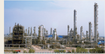
相次いで完成する中国における外資系石油化学コンビナート—最初に完成した BASF の南京コンプレックス
