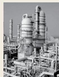
台湾プラスチックグループの麦寮における大規模石油精製・石油化学統合コンプレックス建設—2000年完成の第2期エチレン90万t製造設備
