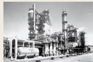
わが国最初のメタロセン触媒による大型設備となった直鎖状低密度ポリエチレン製造設備 (日本エポリユ・千葉)
