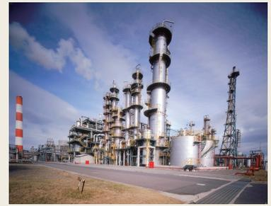
自社技術のエチレン直接酸化法による酢酸製造設備 (昭和電工・大分)
