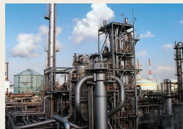
ブタン流動床法を採用した無水マレイン酸製造設備 (MTC ソハイオ・大阪)
