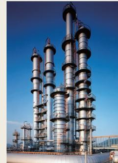
自社新技術のシクロヘキセン法によるシクロヘキサノール製造設備(旭化成工業・水島)
