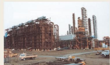
大分コンビナートで建設中の第2 エチレン (エチレン30万t規模) 製造設備 (昭和油化・大分)
