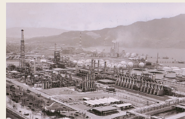
第 2 エチレン製造設備完成当時の出光石油化学徳山工場
