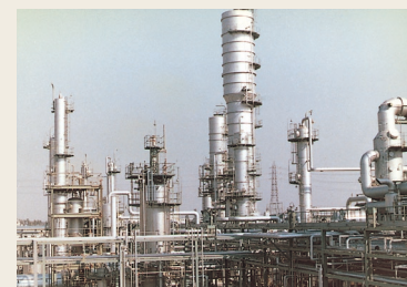
完成した大阪スチレン工業大阪工場のスチレンモノマー製造設備
