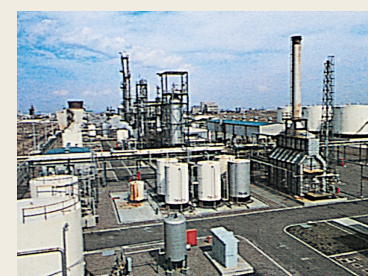
わが国初の合成アルコール製造設備(日本合成アルコール・川崎)
