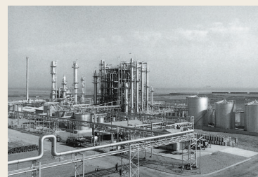
プロピレン法によるわが国最初のアクリル酸製造設備とアクリル酸エステル製造設備 (日本触媒化学工業・姫路)
