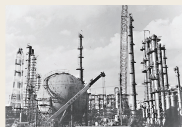
建設が進むエチレン 30 万 t 製造設備 (三菱油化・鹿島)
