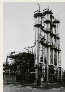
直接水和法によるイソプロピルアルコール製造設備 (徳山曹達・徳山東)
