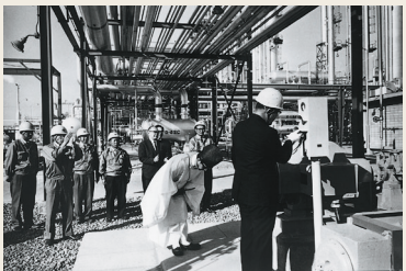
住友千葉化学工業の第 1 エチレン工場油入式
