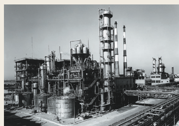
副生硫安を大幅に少なくした DSM 法カプロラクタム製造設備 (宇部興産・堺)
